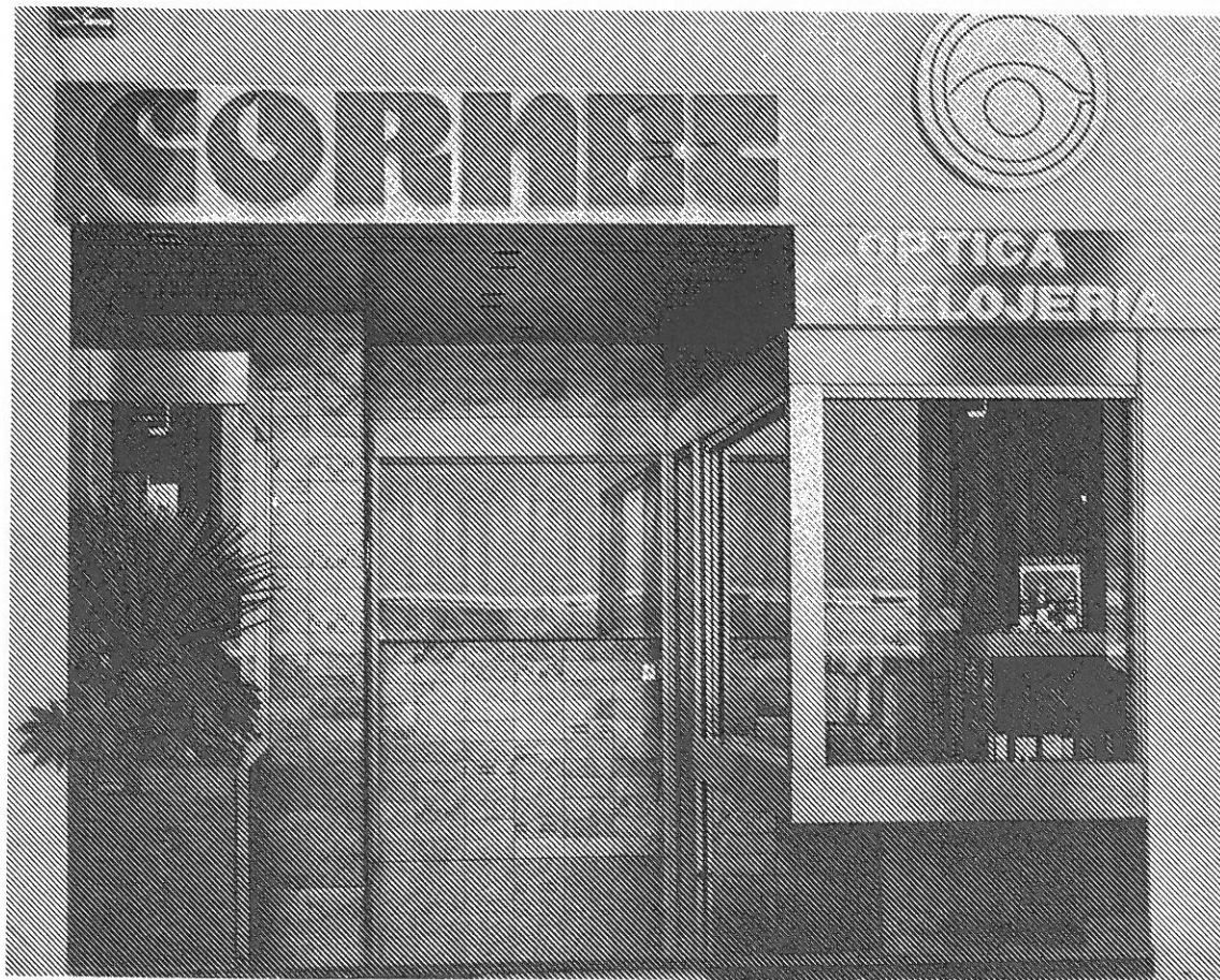
Vista de fachada de nuestras nuevas instalaciones en Gral. Mola, 37 (Frente a la Redonda)
