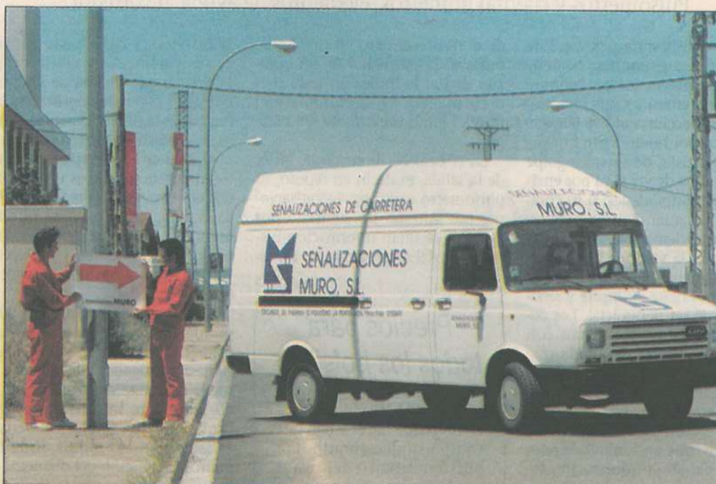
Un equipo de Señalizaciones Muro en el momento de colocación de las flechas que dirigen la dirección de la carrera.
